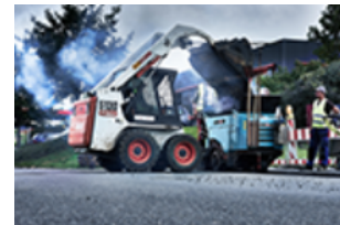
A1508_Befuellvorgang.jpg Das Mischgut kommt vom LKW, der abseits der Baustelle steht und ein kompakter Lader befüllt den Fertiger. Dabei entstehen keine Verkehrsbehinderungen.
