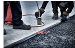
A1508_Fugenband.jpg Das Fugenband wird erhitzt und schließt dann die Lücke zwischen den einzelnen Asphaltsschichten und Einbauten.
