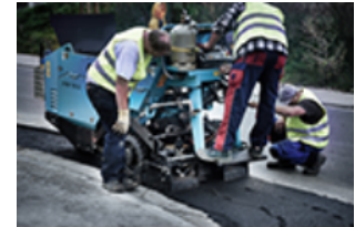
A1508_FertigerimEinsatz.jpg Der Gehwegfertiger AFW 150 G von Ammann ist dank seiner Wendigkeit auf kleinen Baustellen das optimale Gerät.
